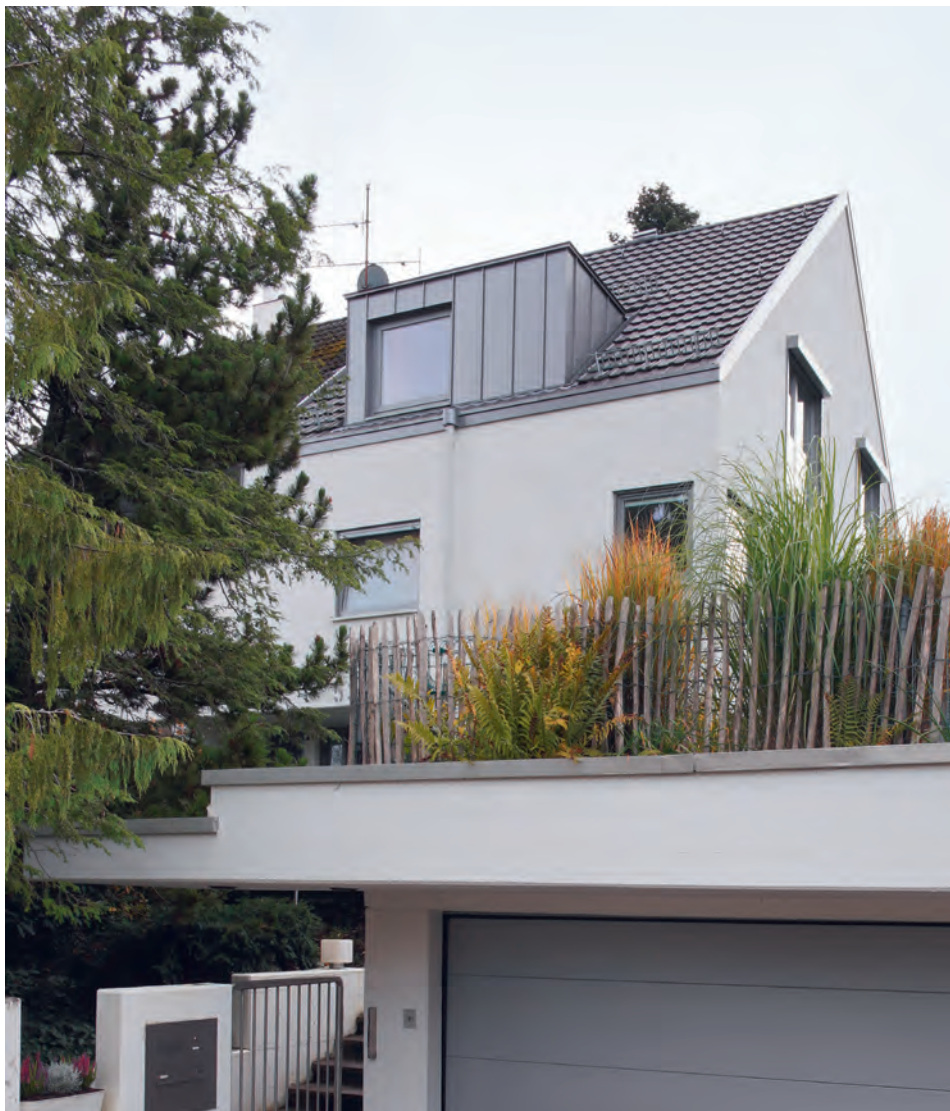
LINKS Eine neue Gaube auf der Eingangsseite verbessert die Belichtung des Dachbereichs.
