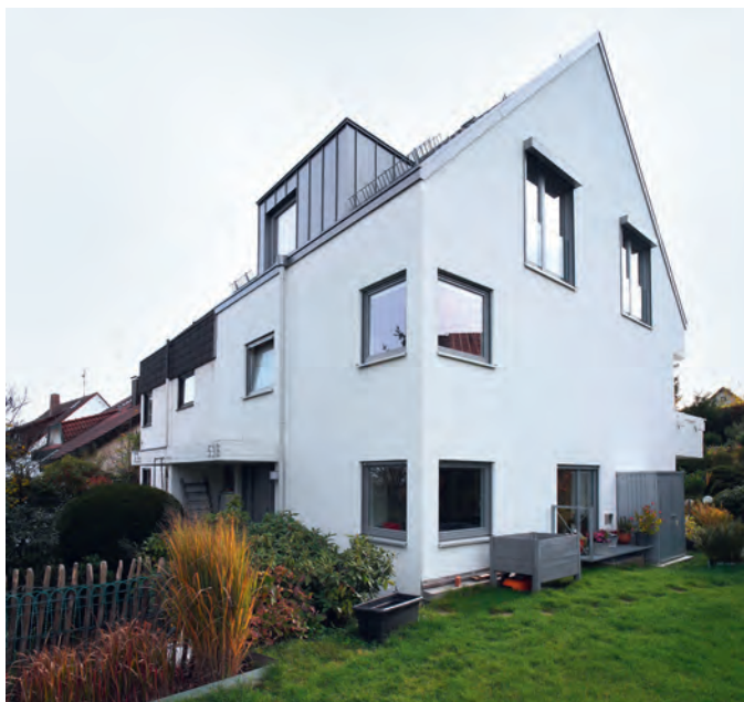
OBEN Ansicht des Hauses mit der Eingangsseite
