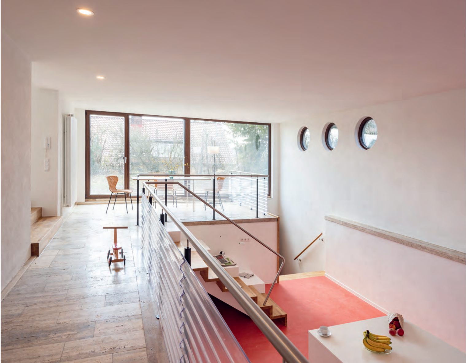
OBEN Blick durch den Raum. Die lichtdurchlässigen Brüstungsfüllungen sind aus Polycarbonatplatten.
